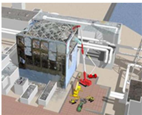
原子炉建屋上部のガレキ撤去
