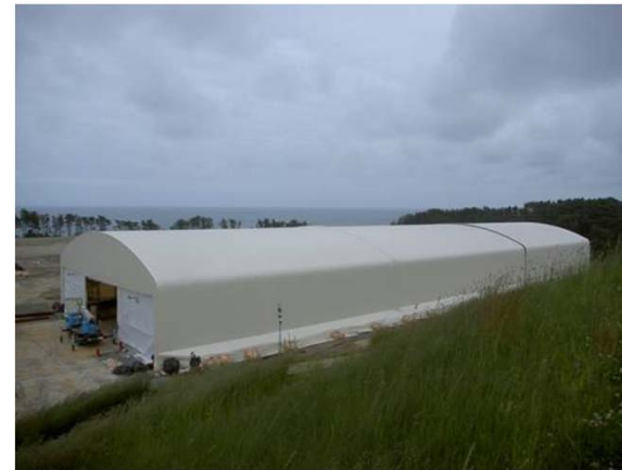
覆土式一時保管施設準備工事完了
