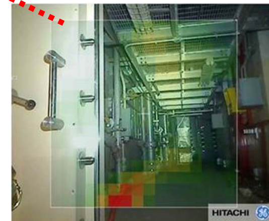
1号機原子炉建屋内線源/線量率 調査 (γカメラによる撮影結果) (5/14~5/18/2012)
