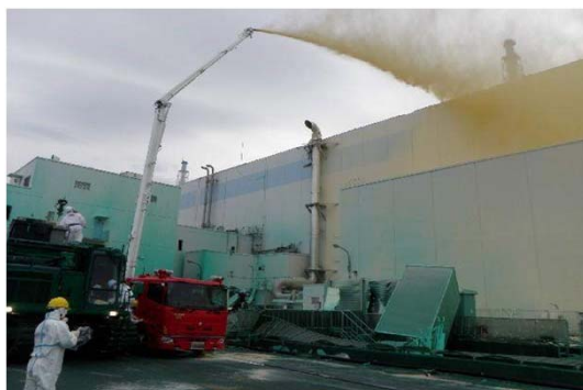
敷地、建屋本体への飛散防止剤散布
