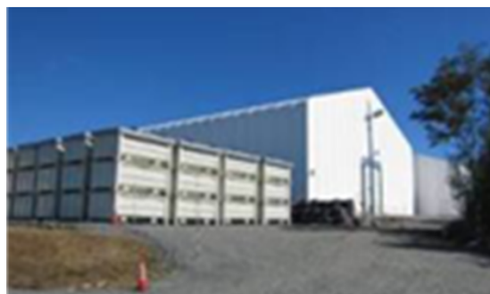
瓦礫保管テント、収納容器
