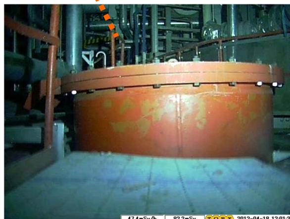
2号機トラス室内調査 (4/18/2012)
