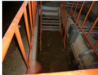
3号機階段室(北西)
