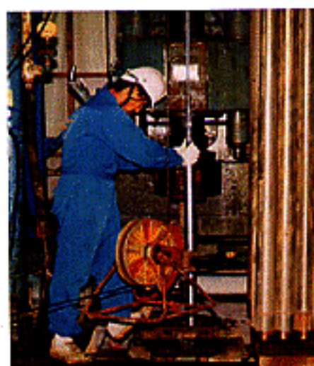
地下深部の岩盤の調査風景
