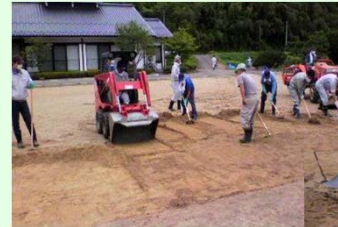
ポリオン/粘土による表土剥ぎ取り作業
