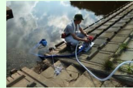
ポリオン/粘土による表土剥ぎ取り作業
