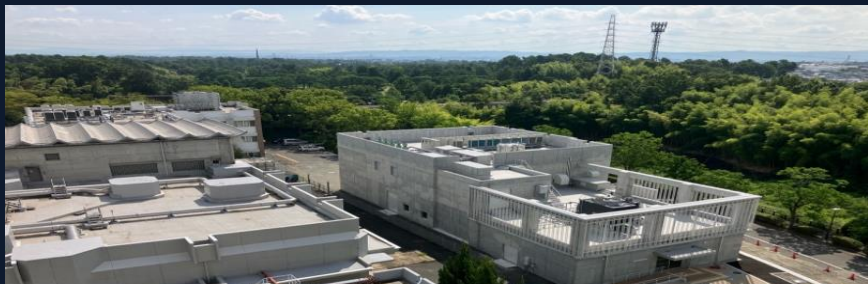
隣棟屋上からの俯瞰写真
