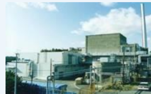
解体中の原子力施設
