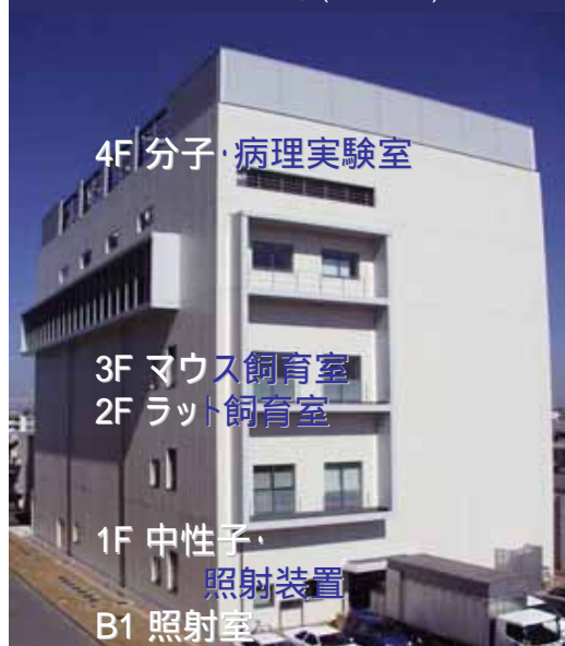
低線量影響実験棟 (H16年)
