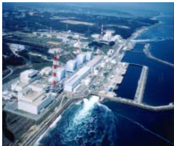
写真 5.1.4 東京電力福島第一1号
