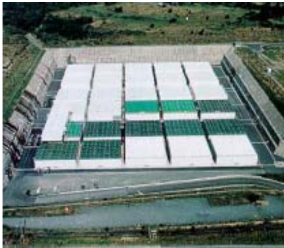
写真 4.3.1.1 発電所廃棄物の処分場、日本原燃(株)低レベル放射性廃棄物埋設センター（青森県六ヶ所村）のコンクリートピット。この隙間にセメントが注入される。
