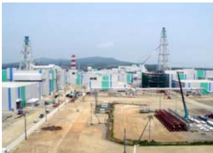
写真 4.1.2.1 六ヶ所再処理工場の建設状況
