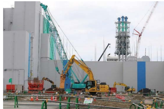
図 2-28 日本原燃六ヶ所再処理工場の冷却塔移設工事（竜巻対策）の様子
