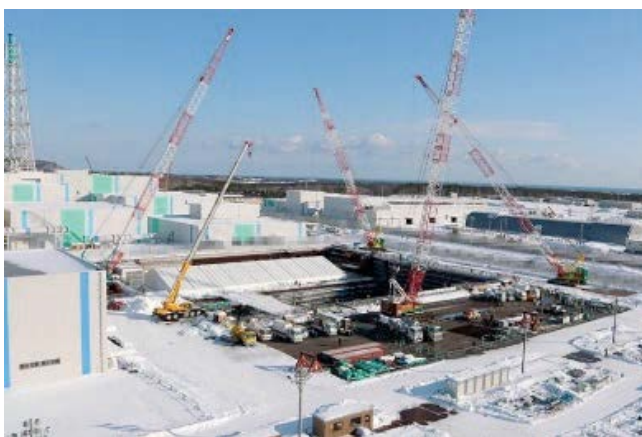
図 2-29 日本原燃 MOX 燃料加工施設の建設工事の様子（2021 年 1 月）
