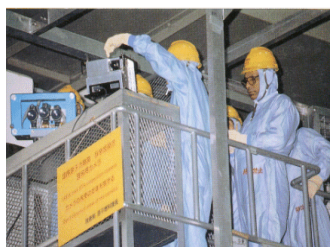
監視カメラの設置
