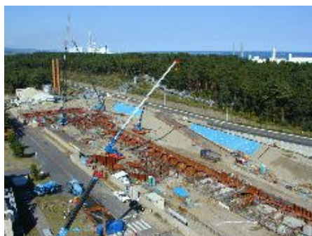
第4-4図 建設状況
