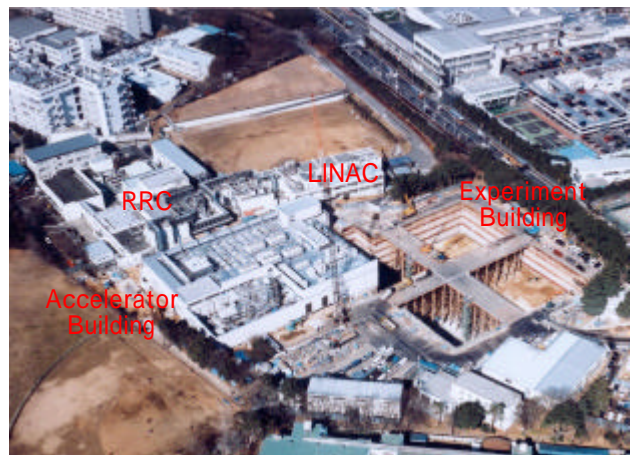
第4-7図 RIBF建設現場
