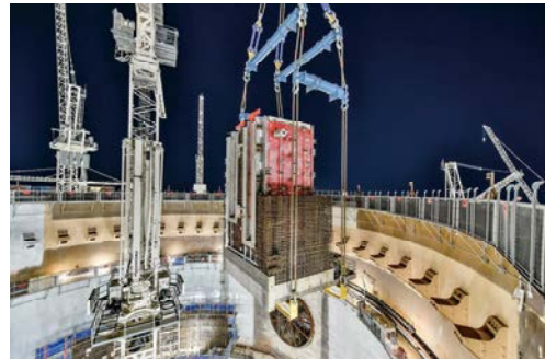
図3-2 建設中のヒンクリーポイントC原子力発電所
