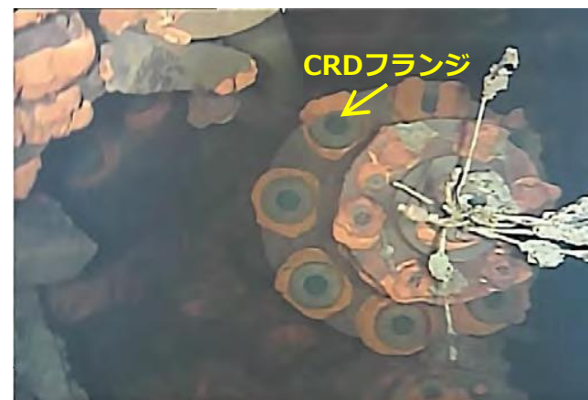
写真3. 3号機で確認されたCRD
