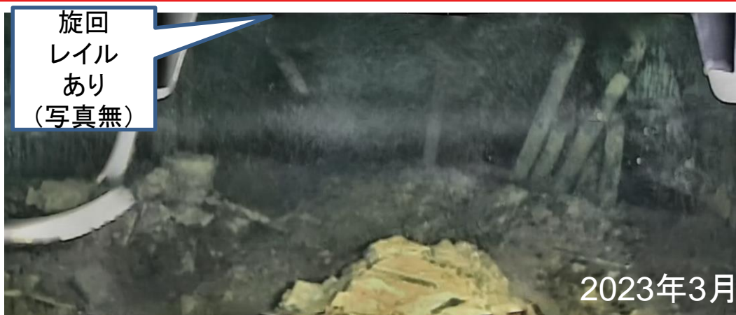
写真1. 1号機のペDESTAL内の状況
