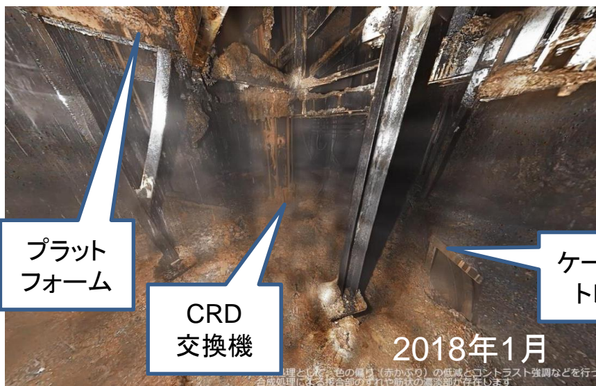
写真2. 2号機のペDESTAL内の状況
