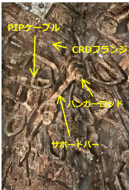
写真2. 2号機で確認されたCRD
