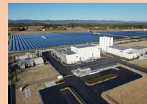
水素エネルギーネットワーク (水素製造施設)
