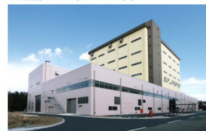
全景 (南西より)
