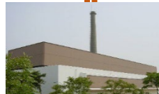
高レベル放射性物質取扱い施設 (CPF)
