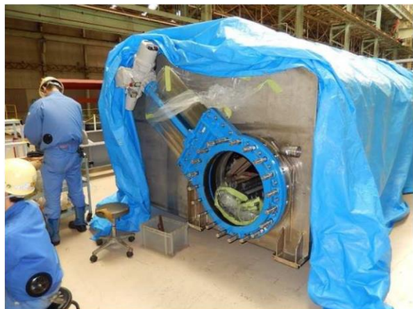
エンクロージャ養生除去作業状況
