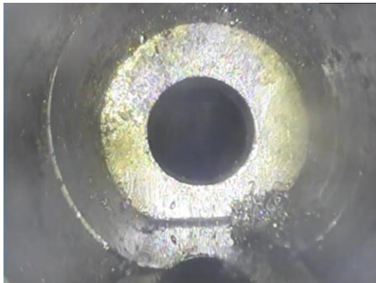
ペネ孔径拡大前 (孔径φ50)
