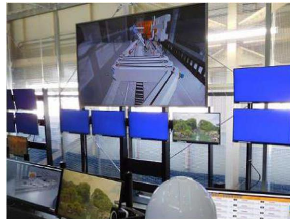
コントロールルーム内状況
