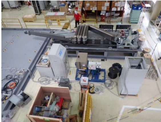
ロボットアーム設置状況
