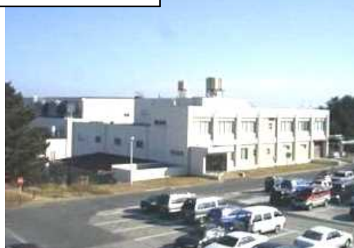
第3廃棄物処理棟
