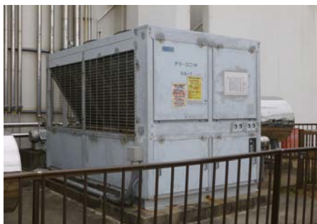
高経年化対策 低放射性固体廃棄物貯蔵場冷凍設備の更新 (核燃料サイクル工学研究所)
