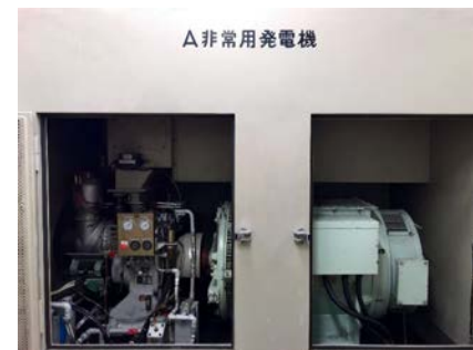
高経年化対策 JRR-3非常用電源設備の一部更新 (原子力科学研究所)
