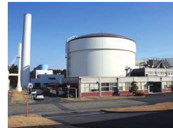
JRR-3 中性子利用施設
