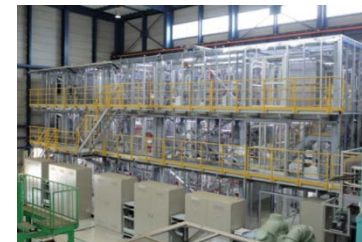
連続水素製造試験装置
