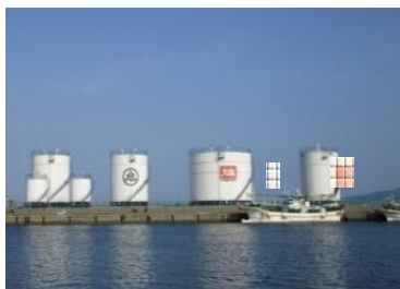
<離島における油槽所>
