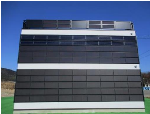
<壁面設置太陽光発電>
