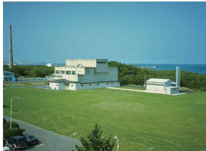
解体終了後のJPDR跡地
