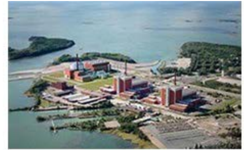
オルキルオト原発の全景(奥が3号機)
