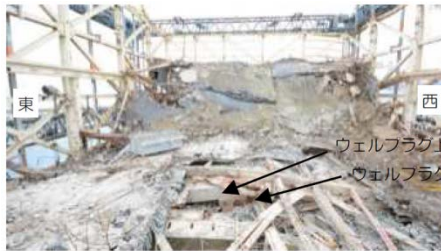
<オペフロの様子（崩落屋根等）>
