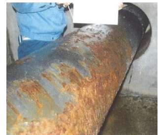
屋外配管外面腐食補修対応 (原子炉廃止措置研究開発センター)
