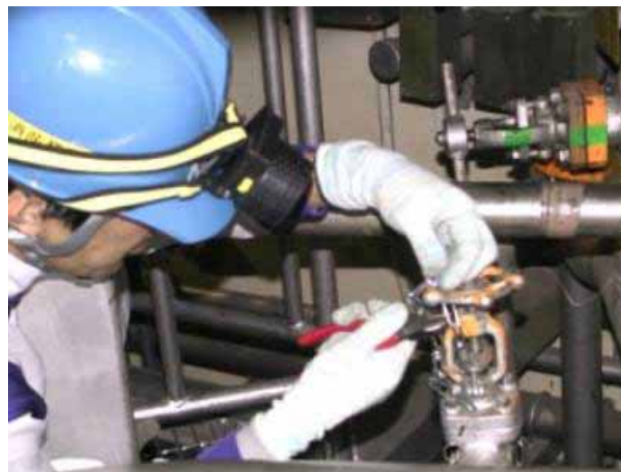
原子炉格納容器漏洩率検査終了時の封印解除例
