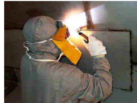
補修作業の様子
