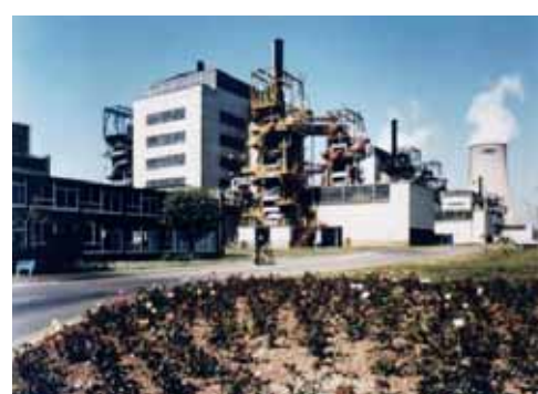
世界初の商用発電(炭酸ガス冷却炉) コールダーホール(6万kW) 1956
