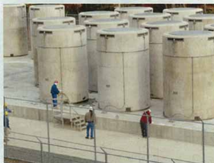
コンクリートキャスク貯蔵 (コネティカットヤンキー原子力発電所)
