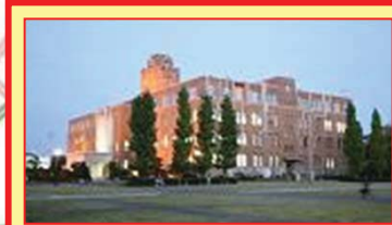
三の丸庁舎 (事案発生現場)
