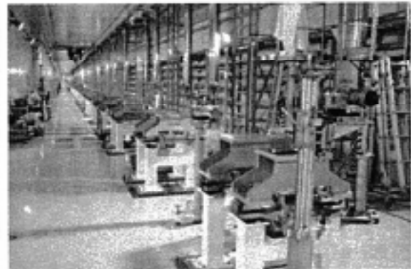
加速器トンネル(加速管設置架台据付工事)
