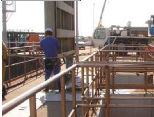
角落としの設置
