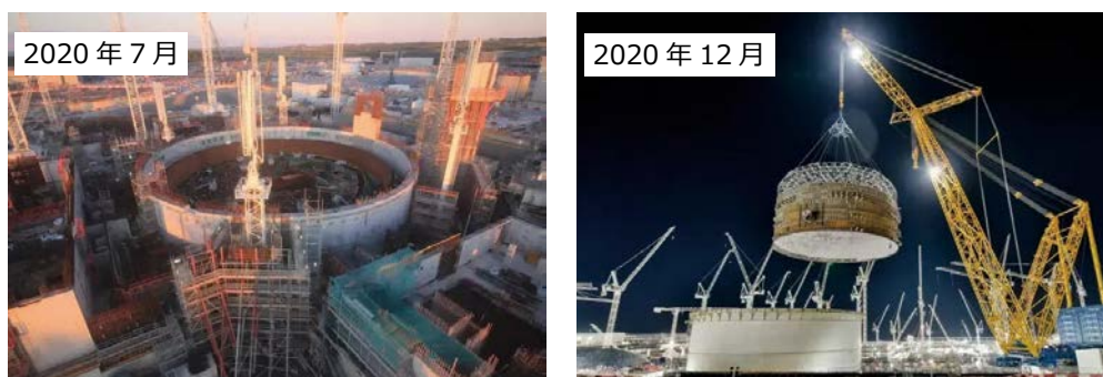
図 3-4 建設中のヒンクリーポイントC原子力発電所
