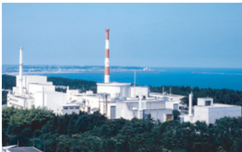
図4-1-7 高速実験炉「常陽」
