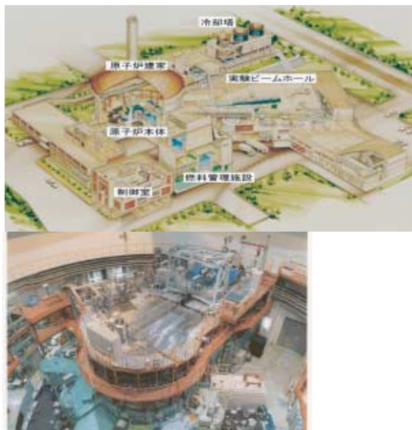
図2-4-7 改造により性能が向上したJRR-3Mの建屋(上)と炉室(下)
