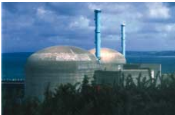
図2-3-7 フランス フラマンビル発電所
