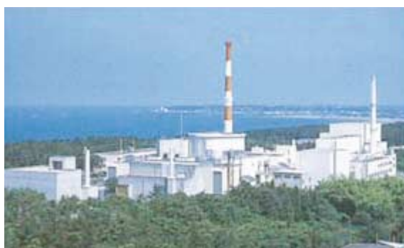
図2-3-22 高速実験炉「常陽」
