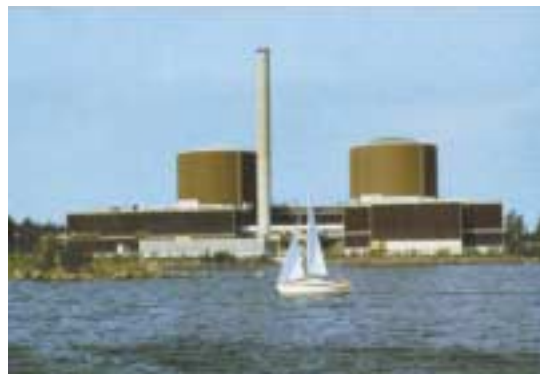
図2-3-11 フィンランド ロビーサ発電所
