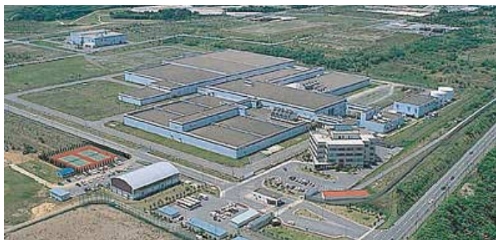
図2-3-18 青森県六ヶ所村 日本原燃（株）ウラン濃縮工場
