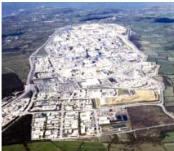
図2-3-32 ラ・アーグ再処理工場(フランス、ラ・アーグ)
