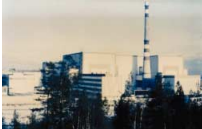
図2-3-13 ロシア コラ発電所
